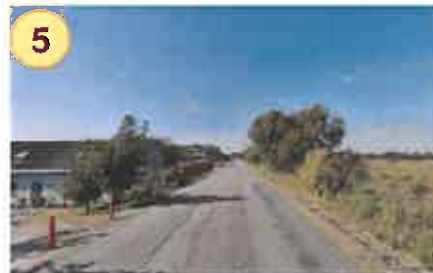
Zouwendijk, Ameide 450-1350 mvt/etmaal
